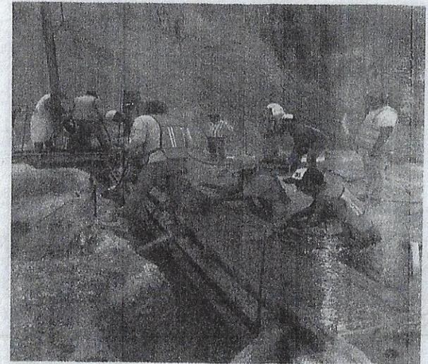
ARMADO, CIMBRADO Y COLADO EN CONTRATRABES Y DADOS EN CIMENTACIÓN DEL EDIFICIO.
