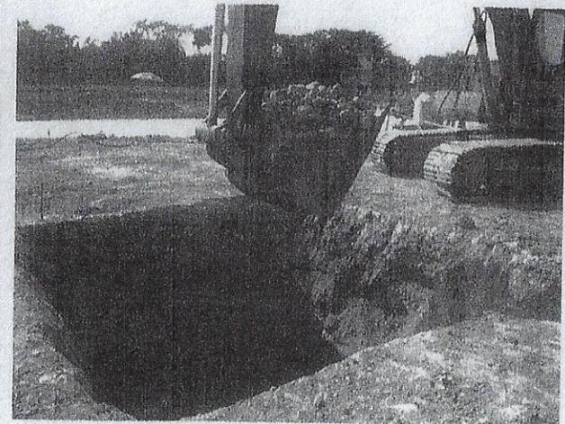
COMPACTACIÓN DE CAPA DE MEJORAMIENTO Y EXCAVACIONES PARA CIMENTACIÓN ÁREA DEL EDIFICIO Y ESTACIONAMIENTO.
