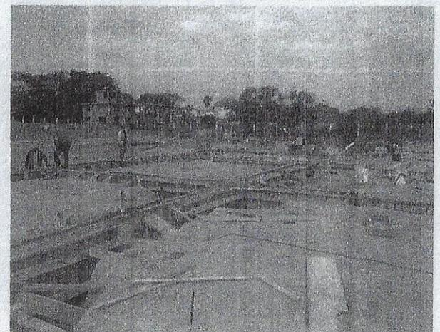
ARMADO CIMBRADO, COLADO DE CONTRATRABES, DADOS EN CIMENTACIÓN DEL EDIFICIO Y CUARTO DE MAQUINAS
