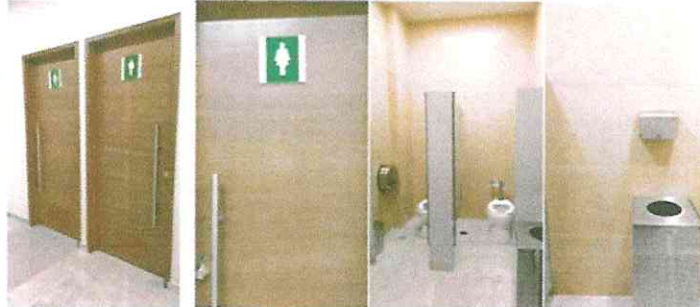
Acceso General a Baños
