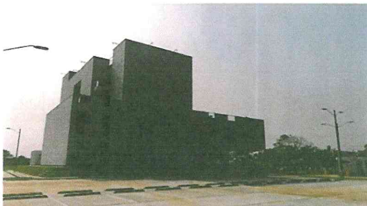
FACHADA VISTA LATERAL LONGITUDINAL
