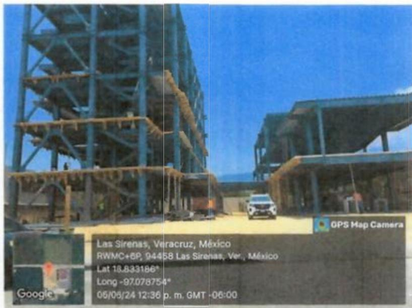
**COLADO DE CAPA DE COMPRESIÓN EN PRIMER Y SEGUNDO NIVEL CON CONCRETO EN EDIFICIO "A" Y PRIMER NIVEL DE EDIFICIO "B".**
