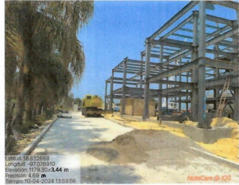
**SUMISTRO, HABILITADO Y MONTAJE DE COLUMNAS Y VIGAS DE ACERO ESTRUCTURAL EN EDIFICIO "B".**
