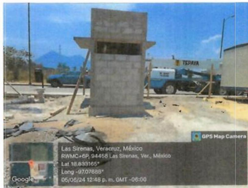
**CONSTRUCCIÓN DE CASETA DE VIGILANCIA Y CONTROL CON CADENAS, CASTILLOS, MUROS DE BLOCK Y LOSA DE CONCRETO.**
