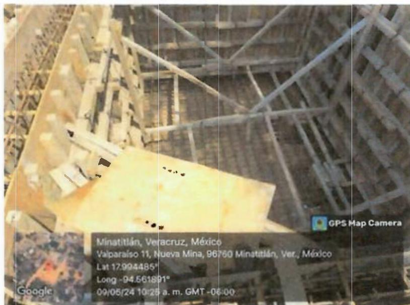
**CONSTRUCCIÓN DE CISTERNA DE CONCRETO REFORZADO.**
