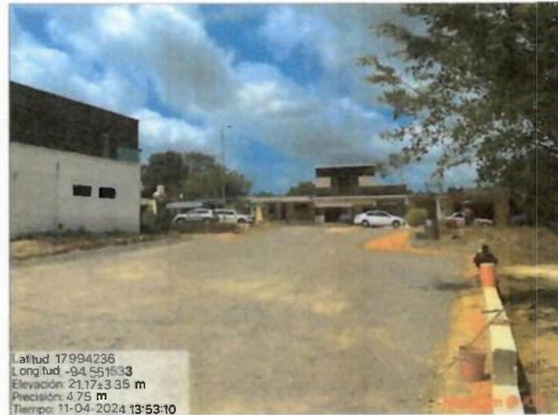
**SUMINISTRO, TENDIDO Y COMPACTADO DE BASE HIDRÁULICA EN ACCESO DE ESTACIONAMIENTO.**
