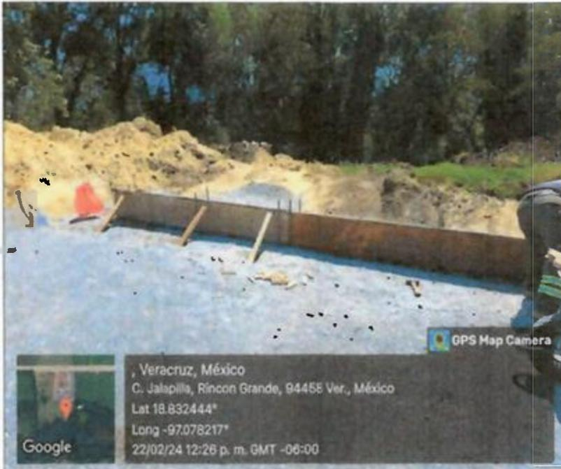
**SUMINISTRO, TENDIDO Y COMPACTADO DE BASE HIDRÁULICA, CONSTRUCCIÓN DE GUARNICIÓN.**
