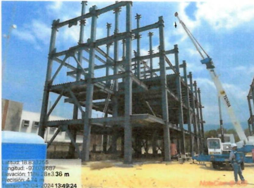
**SUMISTRO, HABILITADO Y MONTAJE DE COLUMNAS Y VIGAS DE ACERO ESTRUCTURAL EN EDIFICIO "A".
