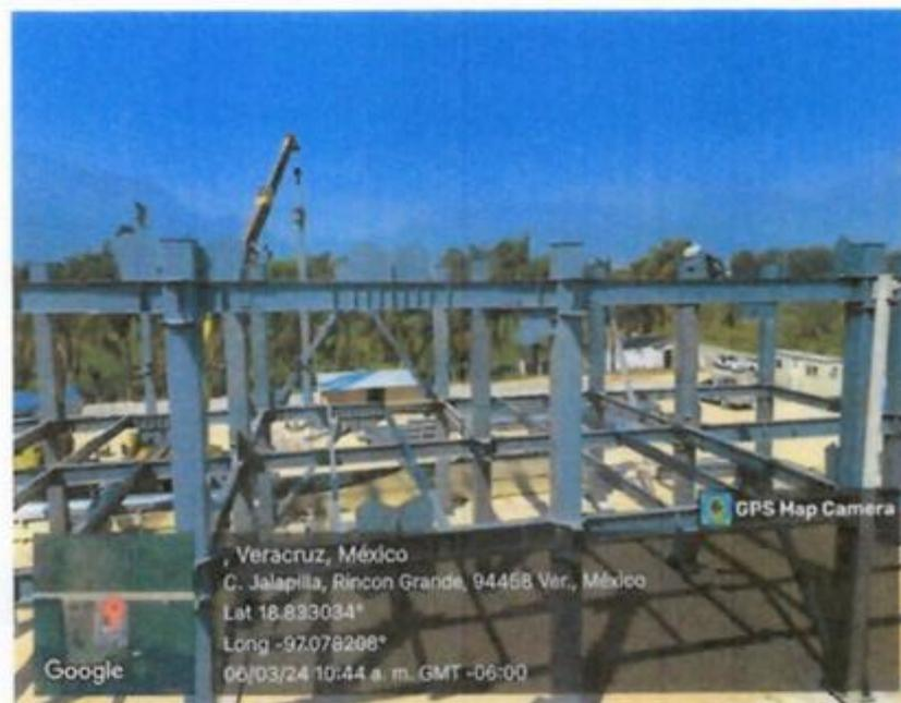
**SUMISTRO, HABILITADO Y MONTAJE DE COLUMNAS Y VIGAS DE ACERO ESTRUCTURAL EN EDIFICIO "A".**
