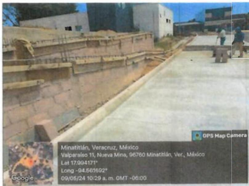
**CONSTRUCCIÓN DE RAMPA CON CADENAS, CASTILLOS Y MUROS DE BLOCK Y VIALIDAD CON CONCRETO HIDRÁULICO.**
