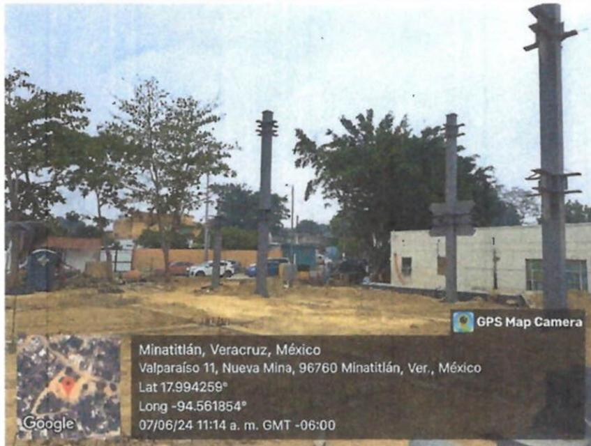
**SUMISTRO, HABILITADO Y MONTAJE DE COLUMNAS DE ACERO ESTRUCTURAL EN EDIFICIO.**
