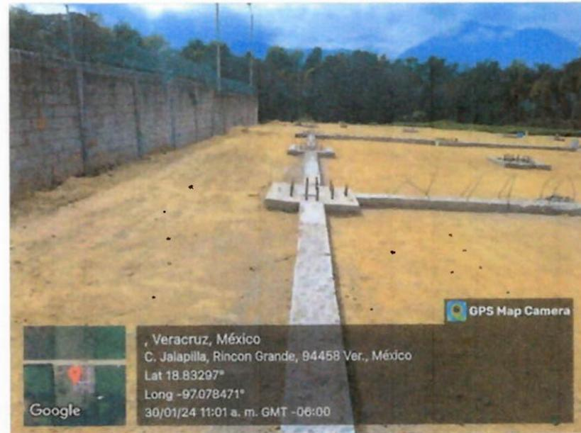
**CONSTRUCCIÓN DE DADOS, TRABES DE LIGA Y ANCLAJE PARA BASES DE COLUMNA DE ACERO ESTRUCTURAL.**
