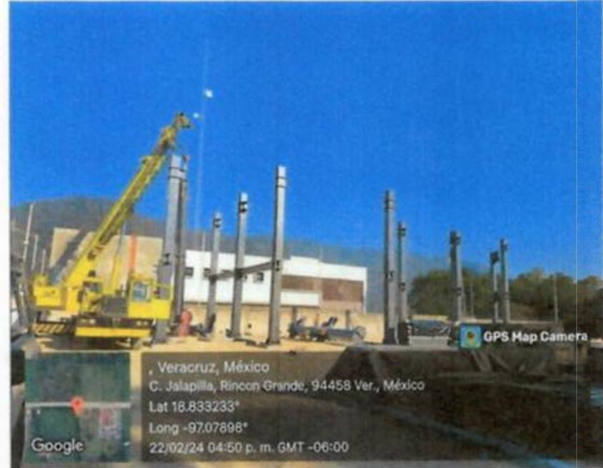
**SUMISTRO, HABILITADO Y MONTAJE DE COLUMNAS DE ACERO ESTRUCTURAL EN EDIFICIO "A".**
