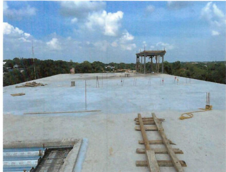
**COLADO DE CAPA DE COMPRESIÓN EN LOSA DE AZOTEA**
